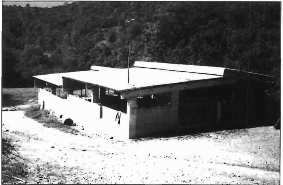
Las instalaciones para ganado ovino en esta zona suelen ser sencillas, utilizando materiales como uralita y ladrillos, y con buena ventilación.
