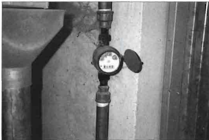
Fig. 10. Para hallar los diferentes consumos entre cerdas refrescadas y no refrescadas se han utilizado contadores adecuados.
