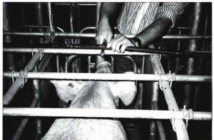
Fig. 5. La instalación del dispositivo de refrigeración por goteo es de extrema sencillez: en el caso de la figura, el tubo de polietileno se despliega sobre las jaulas para cerdas gestantes y se fija a los tubos de las jaulas mismas; después, con tenazas adecuadas, se hacen los agujeros para la inserción de los goteadores.
