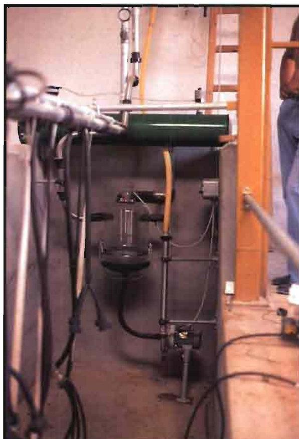
En España se montan, aproximadamente, unas quinientas instalaciones de ordeño de ovino al año.
