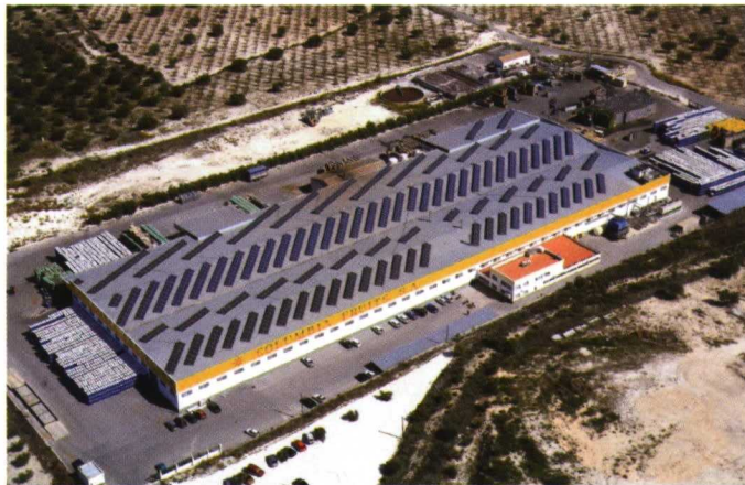
El proyecto llevado a cabo en Molinense Producciones Naturales es una referencia entre las instalaciones para captar energía solar. Ocupa una superficie de 8.000 m 2 y tiene una potencia instalada de 1 MW.
