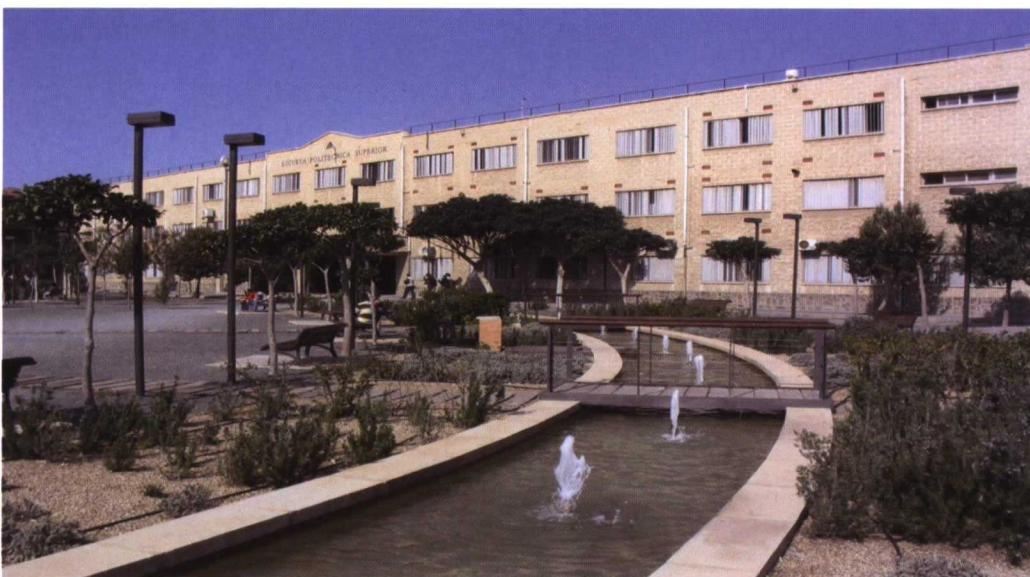
Vista general del exterior de la Escuela Politécnica Superior, en la universidad de Almería.
