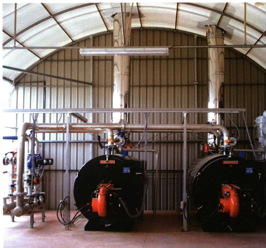
Sistema de calefacción de un invernadero que se calienta con aguas termales.
