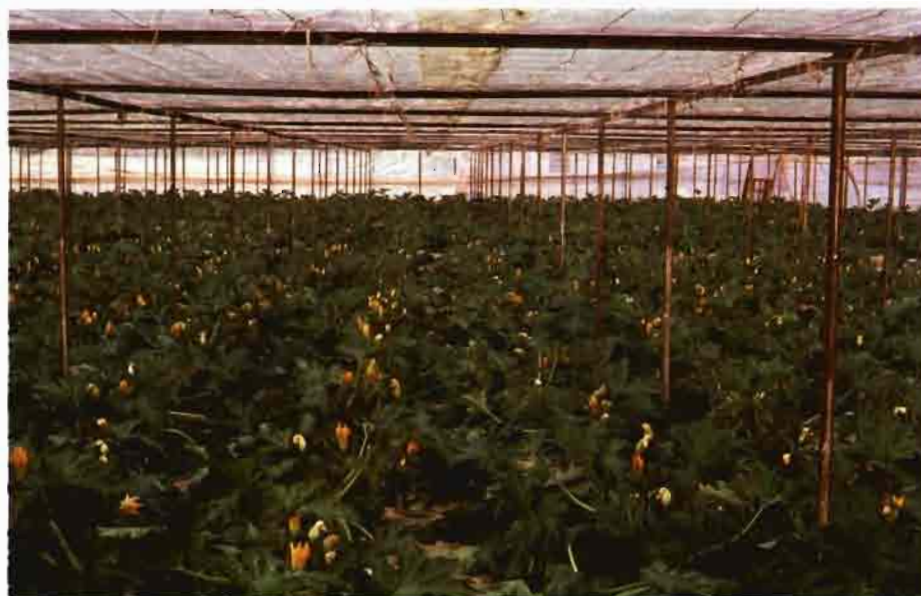
Los invernaderos tipo parral son los más extendidos en las regiones mediterráneas españolas. Sus estructuras no permiten un control climático adecuado pero sus costes de instalación son menores que los de los invernaderos del Norte de Europa.
