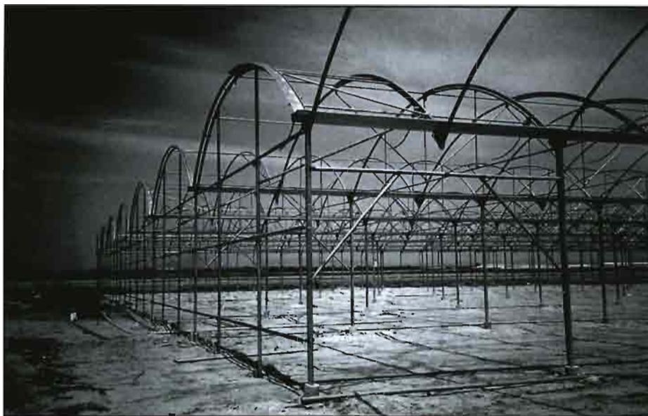
En la fotografía, invernadero multitúnel en construcción
