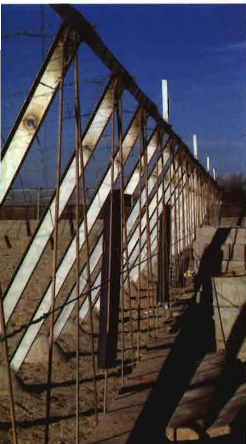
La madera ha sido sustituida por perfiles galvanizados que permiten dar más altura, más solidez y más duración a la estructura, como muestra la fotografía sobre estas líneas. Abajo, sistema tradicional de seto cortavientos y tutores para las plantas a base de cañas y esparto
