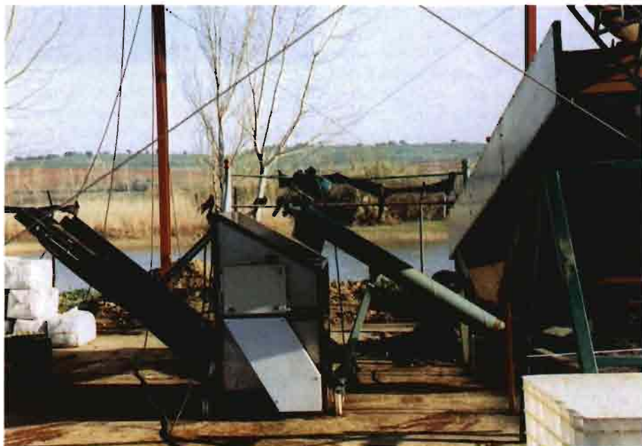
En la fotografía superior, imagen del acopio de residuo de corcho para su posterior compostaje. Sobre estas líneas, imagen de la mezcladora empleada en la elaboración del producto final de sustrato de corcho
