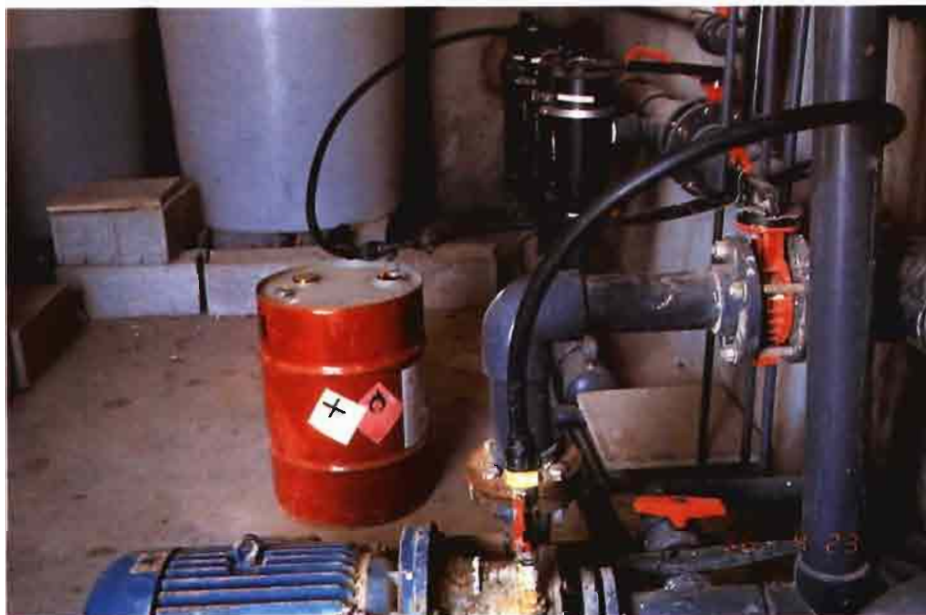
A la izquierda, incorporación del DD a la red de riego mediante un inyector Venturi. En la imagen superior, detalle del Venturi.
