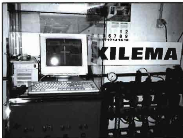
Equipo automático de fertirrigación empleado
