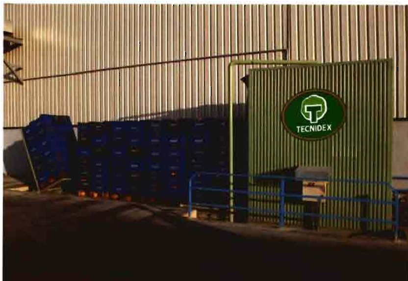
Antes de meter los frutos en las cámaras de desverdización se les aplica, en general, un tratamiento antifúngico en drencher. Foto: Tecnidex.
