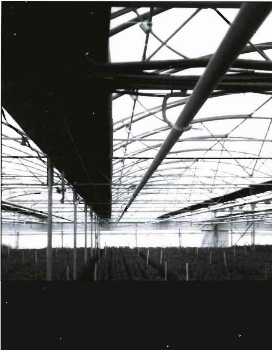
El sistema de pantallas aluminizadas móviles se puede utilizar para evitar la excesiva insolación en verano disminuyendo las elevadas temperaturas. Asimismo en invierno se puede utilizar como doble capa de efecto reflejante durante la noche, permaneciendo recogidas durante el día.
