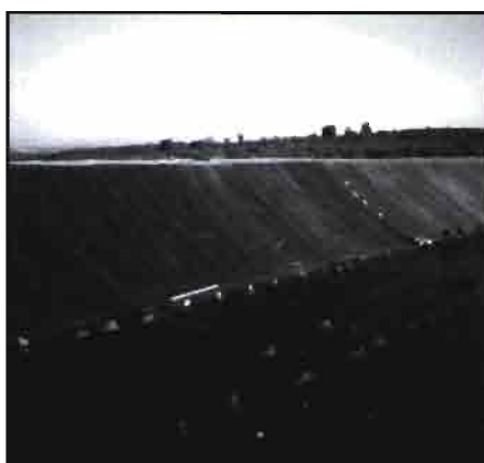
Balsa para aguas de riego impermeabilizada con PEad.
