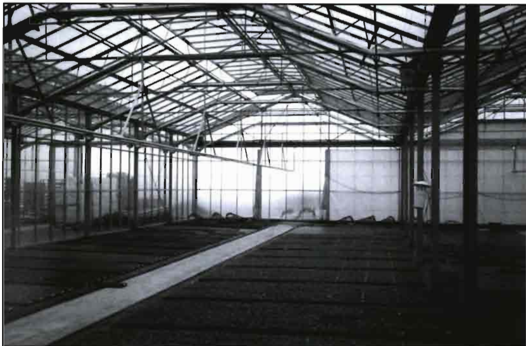
Invernadero de cristal, de C.M.F-Saiga, instalado en un semillero de ornamentales de Cultius Lloveras, en el Maresme - Barcelona.
