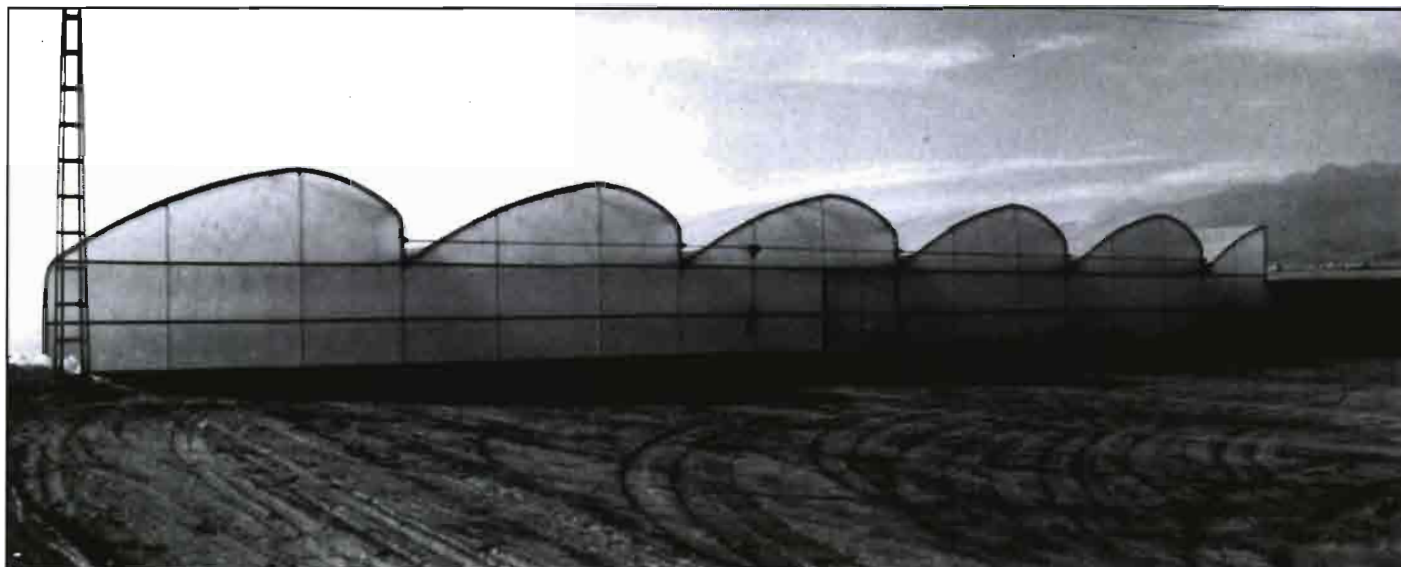
Dos imágenes del «superalm.» En la fotografía superior, una imagen exterior de este nuevo modelo de diseño asimétrico. Debajo vista interior del mismo.
