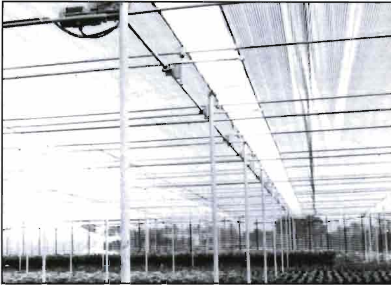
Umbráculo de malla aluminizada con producción ornamental. La imagen muestra la avanzada tecnología de umbráculos con pantalla térmica.
