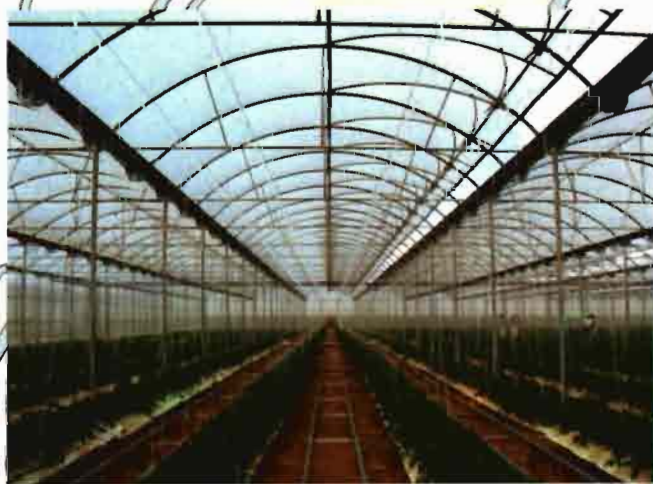
Instalación de HERNANDEZ ZAMORA, S.A. en Mazarrón (Murcia), 130.000 m 2
