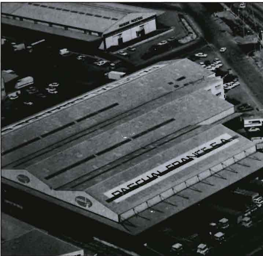
Arriba, detalle del muelle de carga y descarga. En la otra fotografía, vista aérea de la factoría de Agofel (Grupo Pascual) en Perpignan (Francia).
