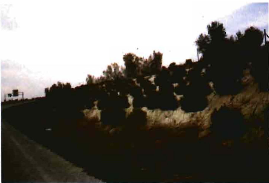
Arriba, cortina arbustiva en la autovía Sevilla-Cádiz. En la otra fotografía, repoblación de taludes en la autovía A-92 Sevilla-Málaga.
