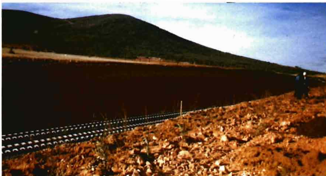
Plantaciones de taludes en la obra del tren de alta velocidad (TAV). Fotografía en Ciudad Real.
