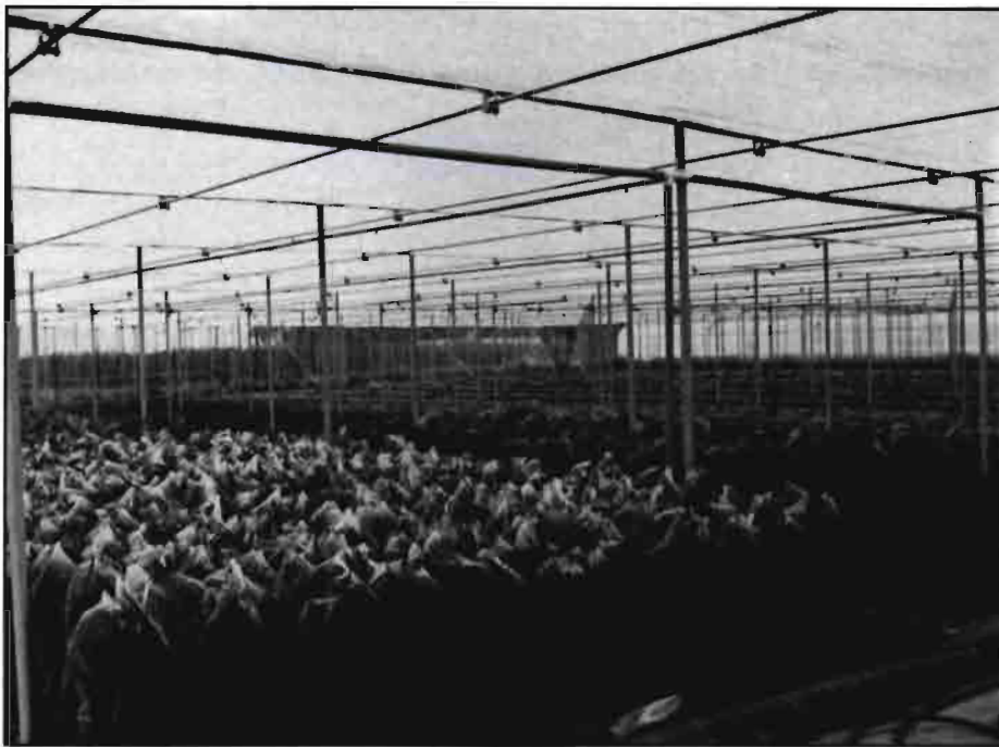
La estructura es de postes de hierro galvanizado de 2" colocados cada 4x4 m y comunicados entre sí a distintas alturas por tubos de 1". En la fotografía, cultivos de diversas plantas de exterior preparadas para su exportación. Eixplant S.A.
