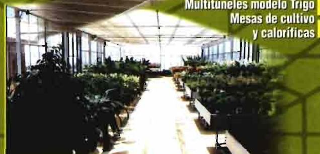
Invernaderos cubiertos en luna de vidrio o policarbonato
