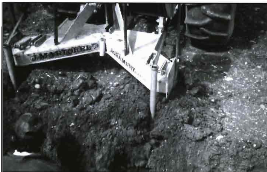
Técnica Copersa. Instalación de dos líneas de cinta T-Tape® TSX 510-60 con un apero arrastrado por un tractor de ruedas. La separación entre líneas es de 120 cm y la profundidad de 55 cm.
