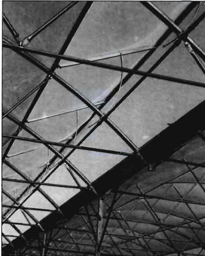
Fijación de la doble capa de plástico en el perfil Super 90® de Filclair.
