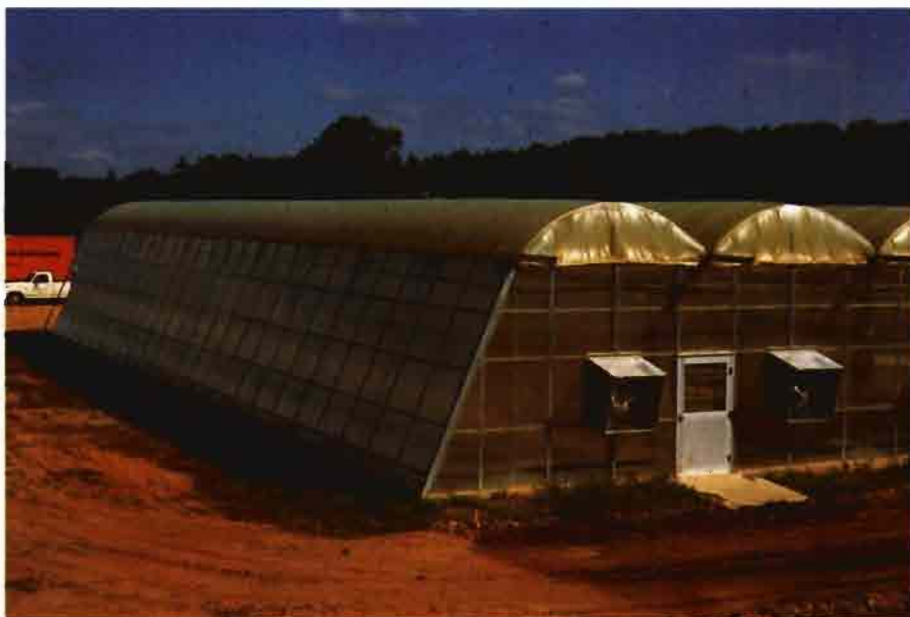
Invernadero de doble pared con plástico de polietileno y laterales de policarbonato en Carolina del Norte (USA). En primer término extractores para la renovación del aire en el interior del invernadero seguramente pertenecientes al sistema cooling. Foto: Comité Internacional de Plásticos en Agricultura.
