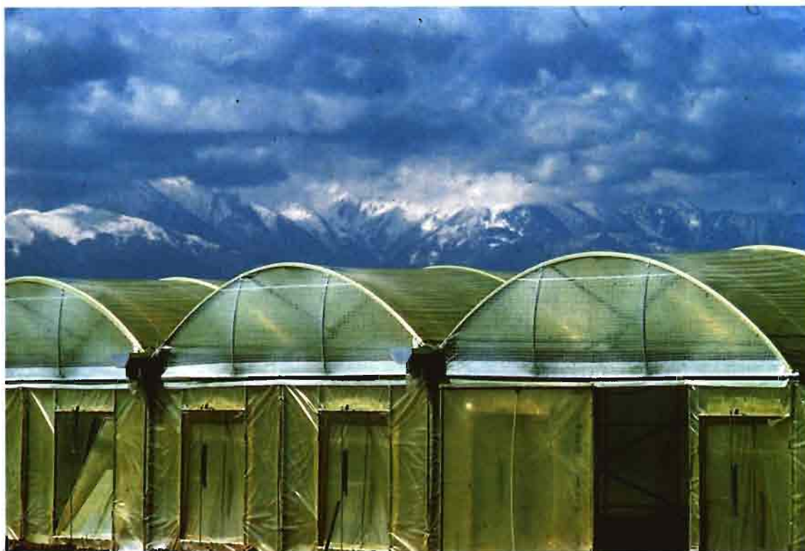
Invernadero multicapilla en Perpignan (Francia). Las paredes de doble pared, dadas sus características de aislamiento térmico, permiten cultivar especies con necesidades de temperatura elevada aún cuando la influencia climática no sea la adecuada. Foto: Comité Internacional de Plastiques en Agriculture.
