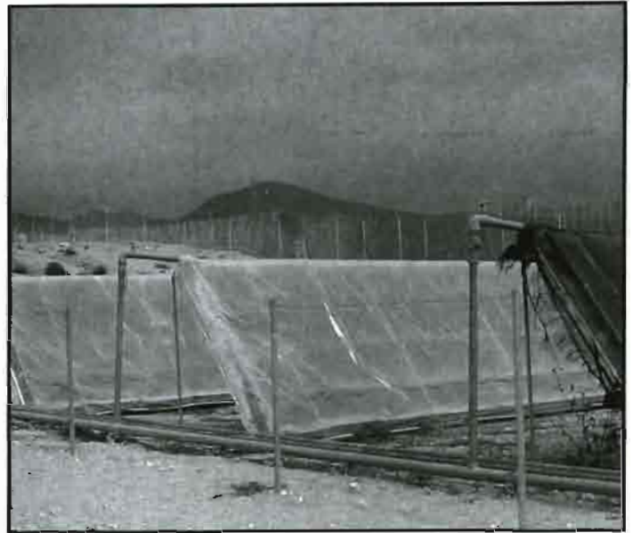
Placas de energía solar para calefacción por agua.
