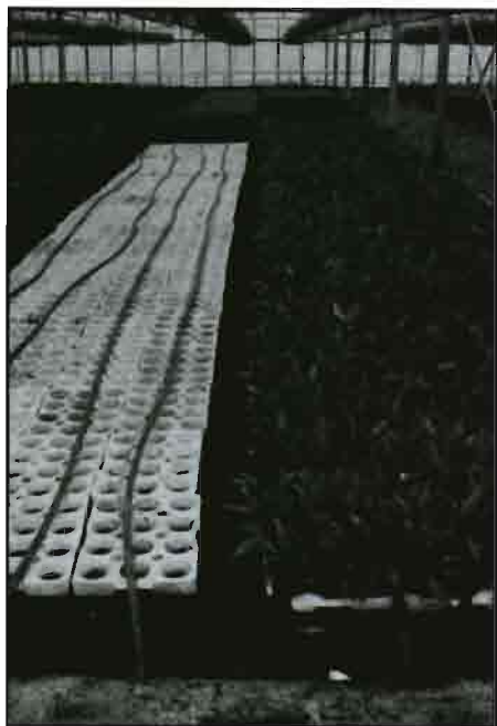
Parte de las instalaciones de Raff Westland BV, cultivadores de planta en maceta. Obsérvense los portamacetas y las tuberías de calefacción.
