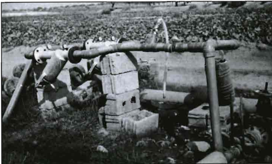
Las primeras instalaciones de riego por goteo en melón fueron muy rudimentarias.
