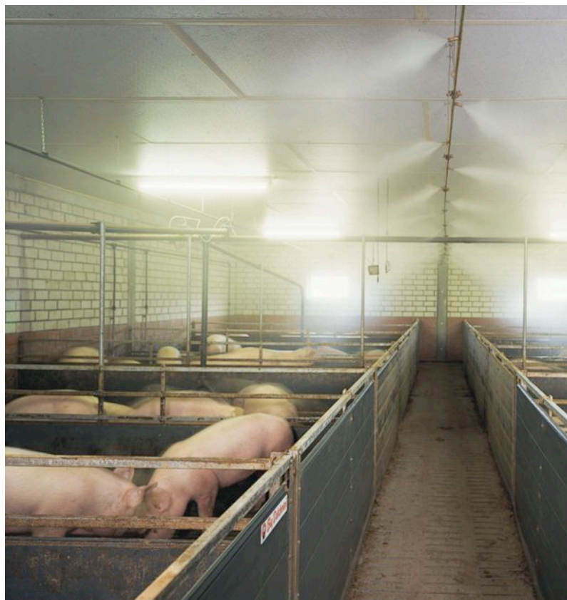
Sistema de nebulización de alta presión para la granja de engorde de cerdos.
