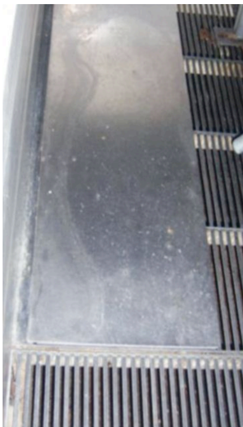
Suelo radiante empleado para mantener el calor de los lechones en las parideras. Fuente: Departamento de producción animal. ETSI Agrónomos. UPM.
