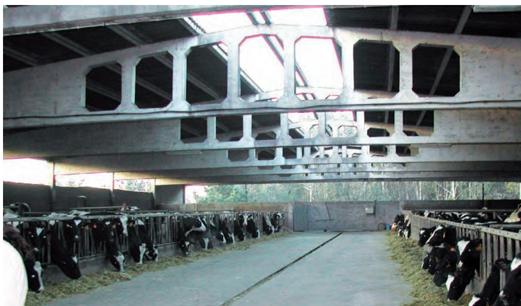
Foto 3 y 4. Naves bien ventiladas (mediante ventiladores o ventilación natural) e higiene adecuada
