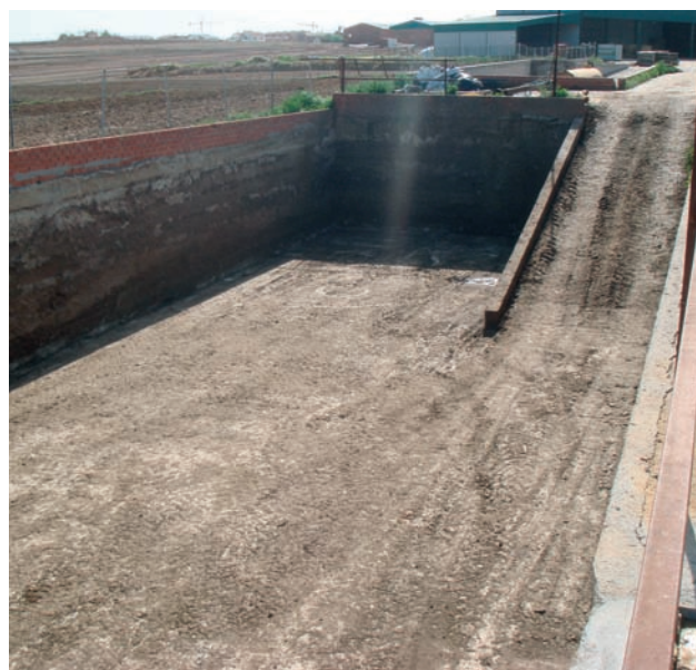
Estercolero, 7 metros de profundidad
