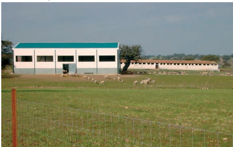
Los antiguos establos al fondo y delante la nave moderna
