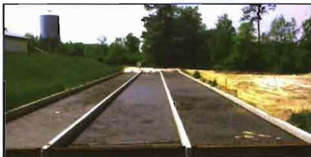
Figura 2. Tanques de un sistema de decantación estática (Mukhtar et al 1999)
