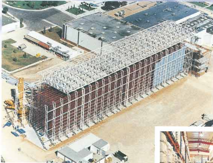
Rack convencional para cargas paletizadas.
