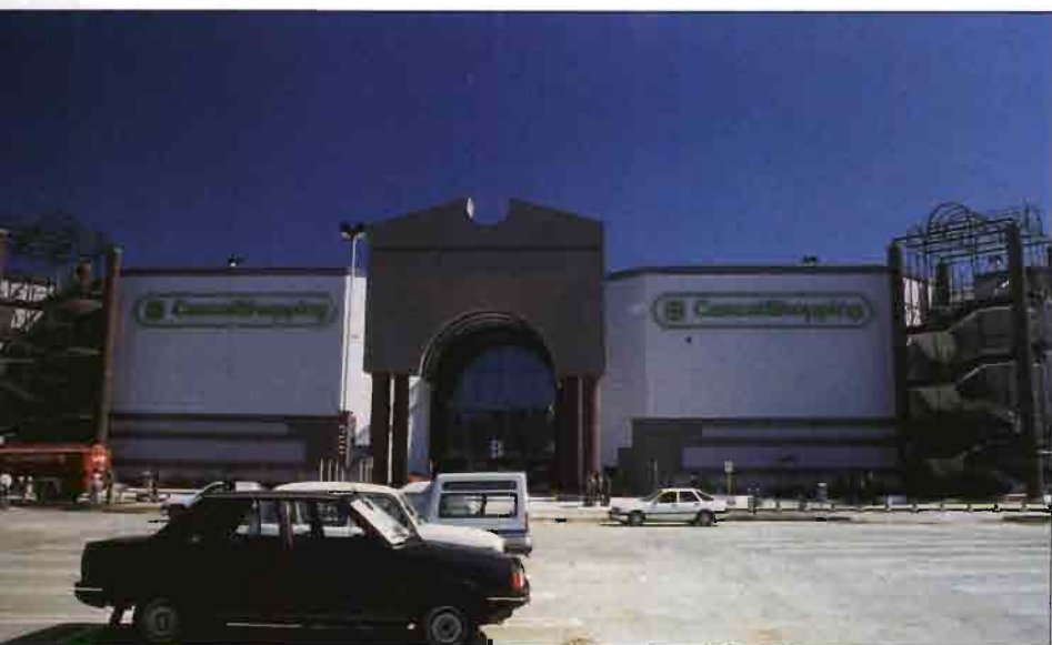
Centro Comercial "Cascais Shopping". Cascais (PORTUGAL).
