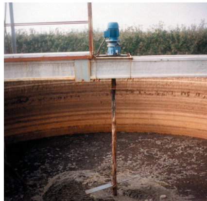
Foto 4. Agitador instalado permanentemente al tanque de purines. A. Magrí.
