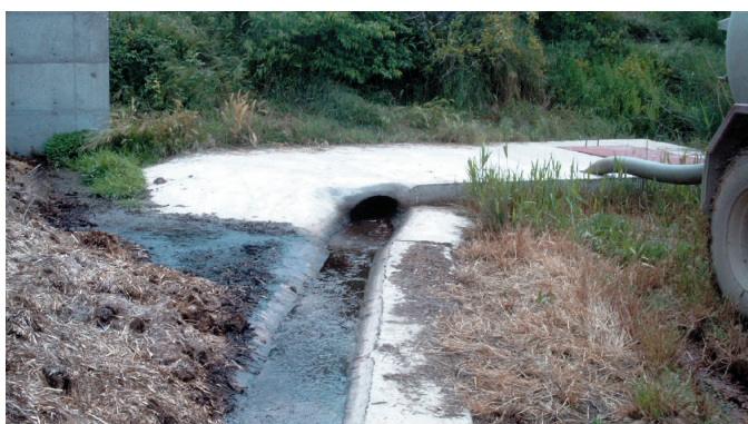
Foto 1. Sistema de recogida de fluidos del estercolero hacia un depósito para el líquido de escorrentía. M.R. Teira.
