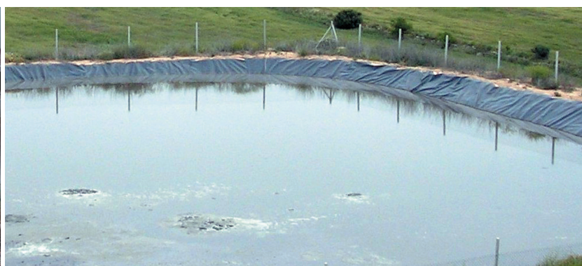
Foto 2. Balsa de purines impermeabilizada con una lámina plástica y cierre perimetral. M.R. Teira.
