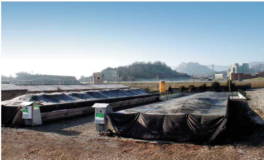
Planta de compostaje. Foto: ECA de l'Empordà.
