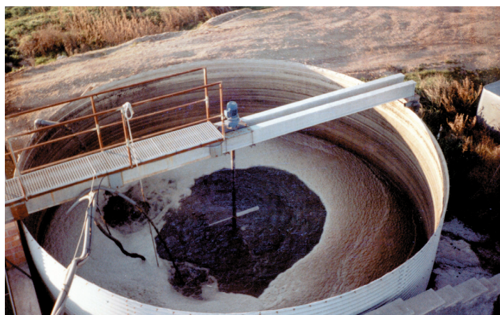
Balsa de almacenamiento de purines en una explotación porcina. Foto: A. Magrí.
