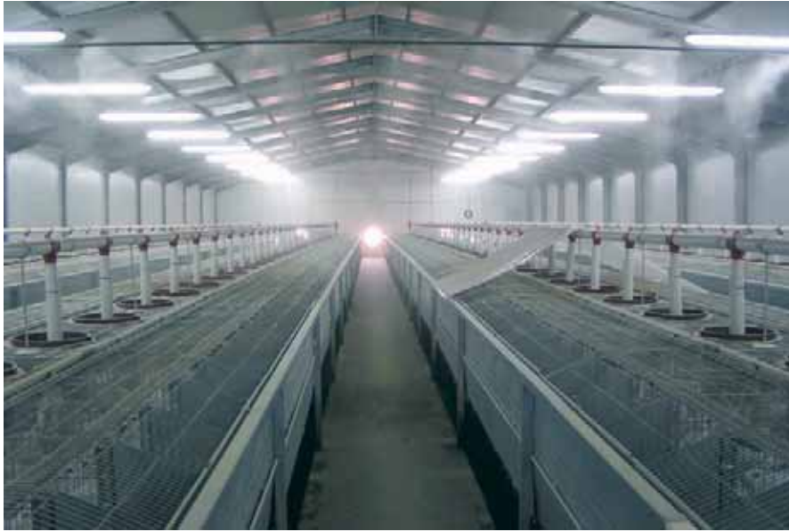
Las naves, de 13 m de ancho por 39 m, de largo están construidas con paneles de tipo sándwich.
