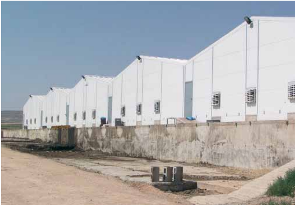
En la zona de salida del aire se encuentra el muelle de carga.
