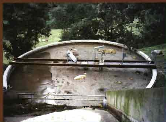
Una pala de arrastre lleva las deyecciones hasta otra fosa que las conducirá a la balsa exterior.
