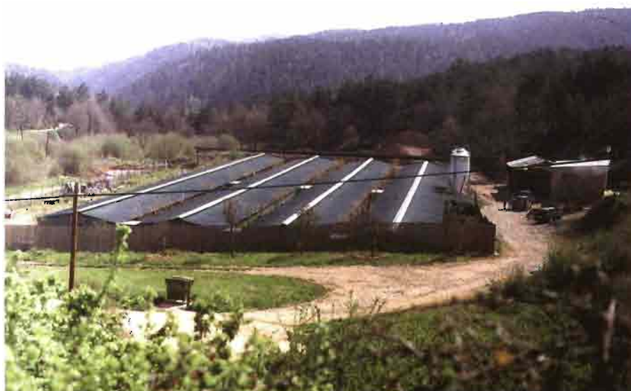
Vista general de las cuatro naves de ambiente natural.
