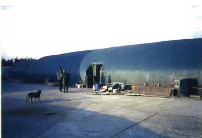
Exterior de una de las parejas de túneles, usados para la maternidad.
