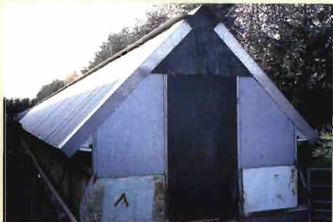
Open-Air cerrado en invierno, con ventilación principal por la cumbre.
