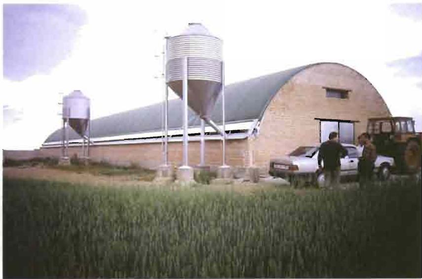
Nave única prefabricada con los silos correspondientes para madres o engorde.
