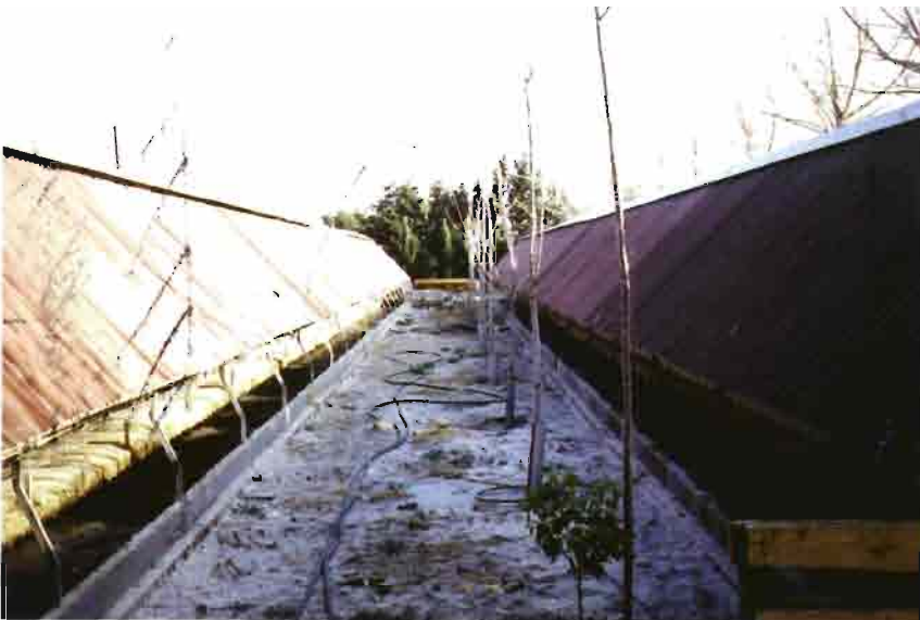
Detalle de la instalación "oper air" con protección de los vientos. Obsérvese la escarba matinal
