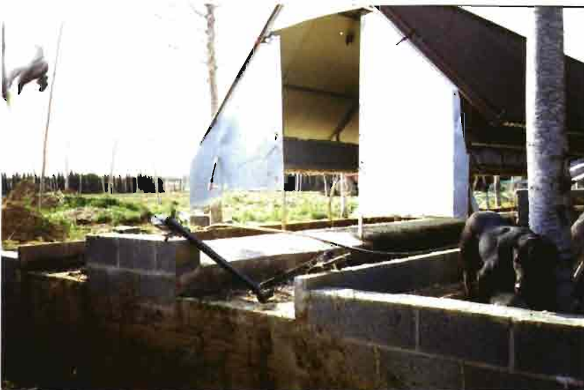
Sistema sencillo para extracción de las deyecciones con un robot mecanizado, en fase de instalación
