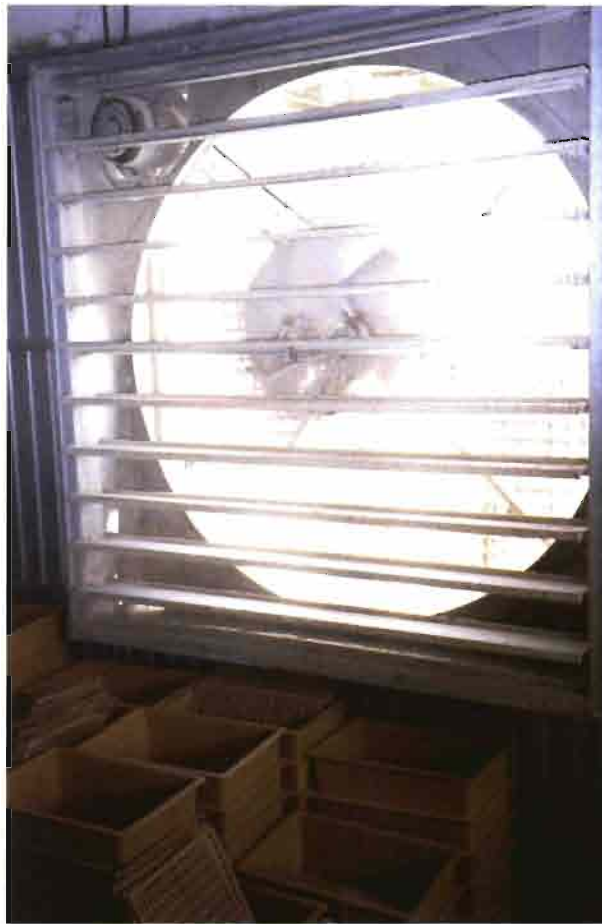
■ El gran extractor, en un extremo de la nave. Ver los nidos cuna con fondo de sandwich.
