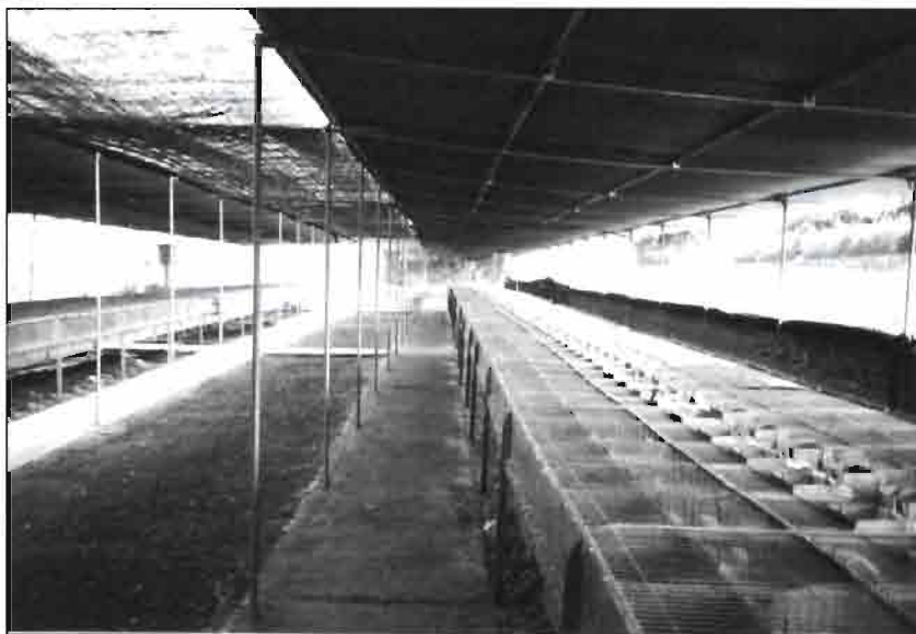
Detalle de la malla de sombra en la cubierta.
