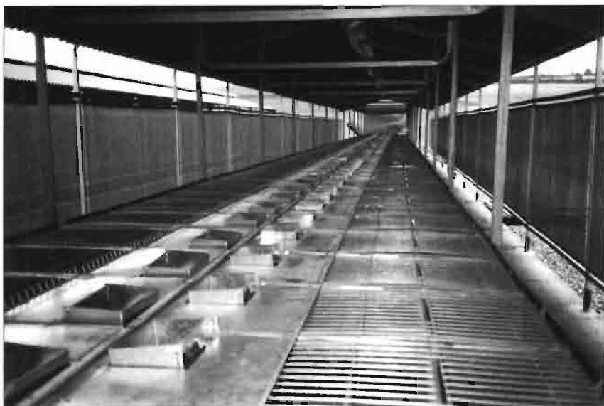
Modelo de estructura ligera con protección lateral en forma de malla de plástico, para aislamiento de los vientos.
