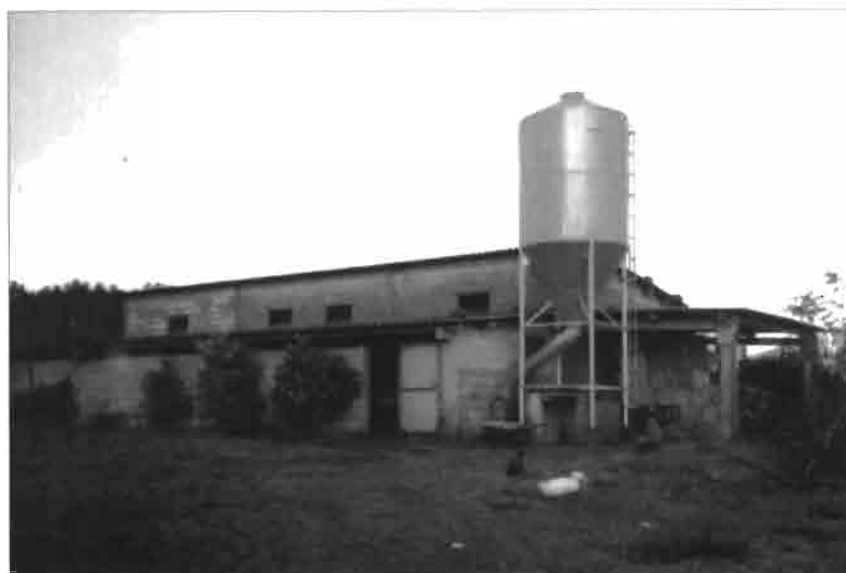
Modelo característico de una nave existente aprovechada y acondicionada para cunicultura.
