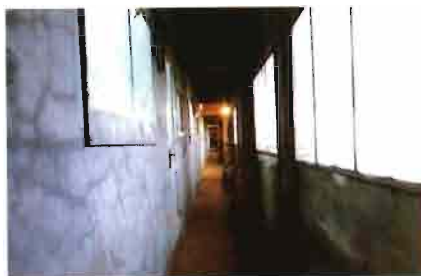
Vista del pasillo de manejo de la nave de maternidad.
