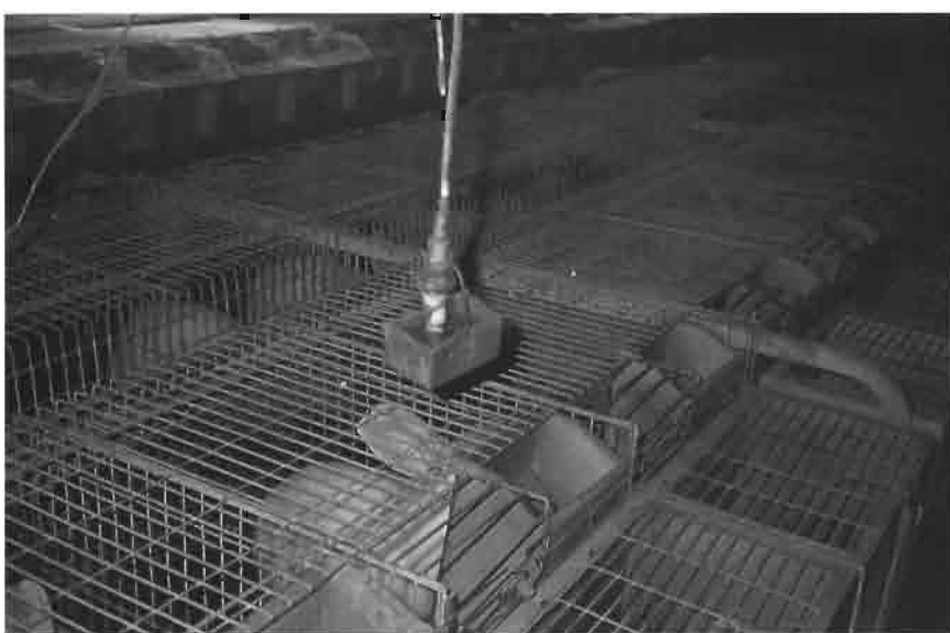
Fig. 6 Detector climático a nivel de los animales en las naves de maternidad.
