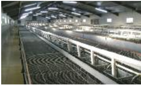
Interior de una de las naveas después del vacío sanitario.
